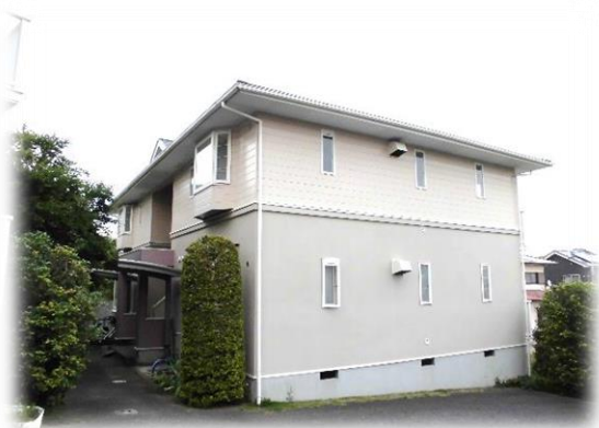
グループホーム「颯 (SOO)」I・II 外観
